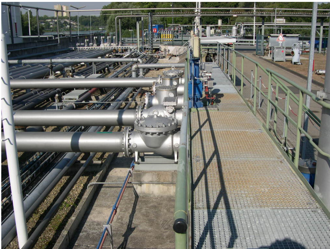
Abb. 4: Rückschlagklappen nach dem Manifold, Tanklager links
