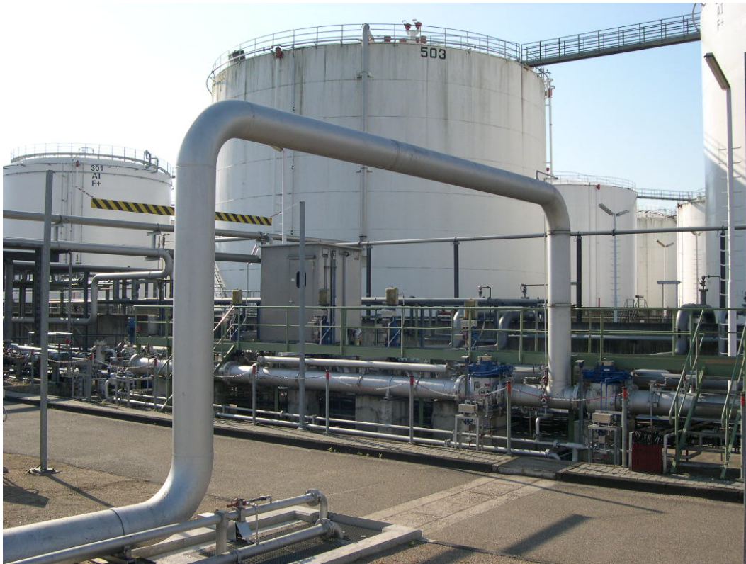
Abb. 3: Zuleitung zum Manifold
