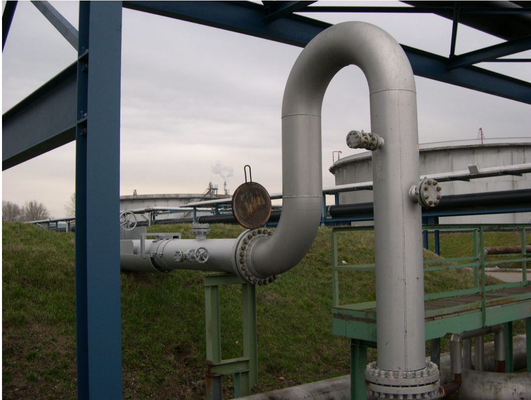
Abb. 5: Brillensteckscheibe als definierte Schnittstelle zwischen Rohrfernleitung und Tanklager
