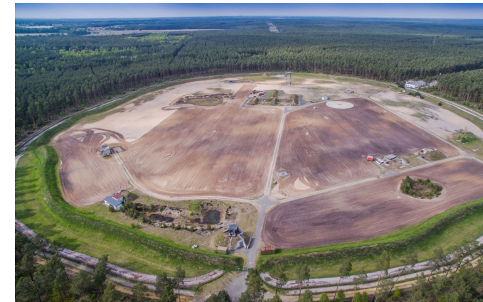
Sprengplatz 1 auf dem BAM Testgelände Technische Sicherheit
